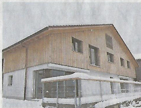
Trois appartements labellisés Bois suisse ont pris la place de l'ancienne menuiserie.
